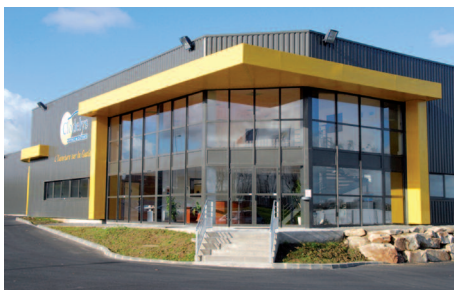
SCI les Hautes Clôtures à Saint-Malo (35)
